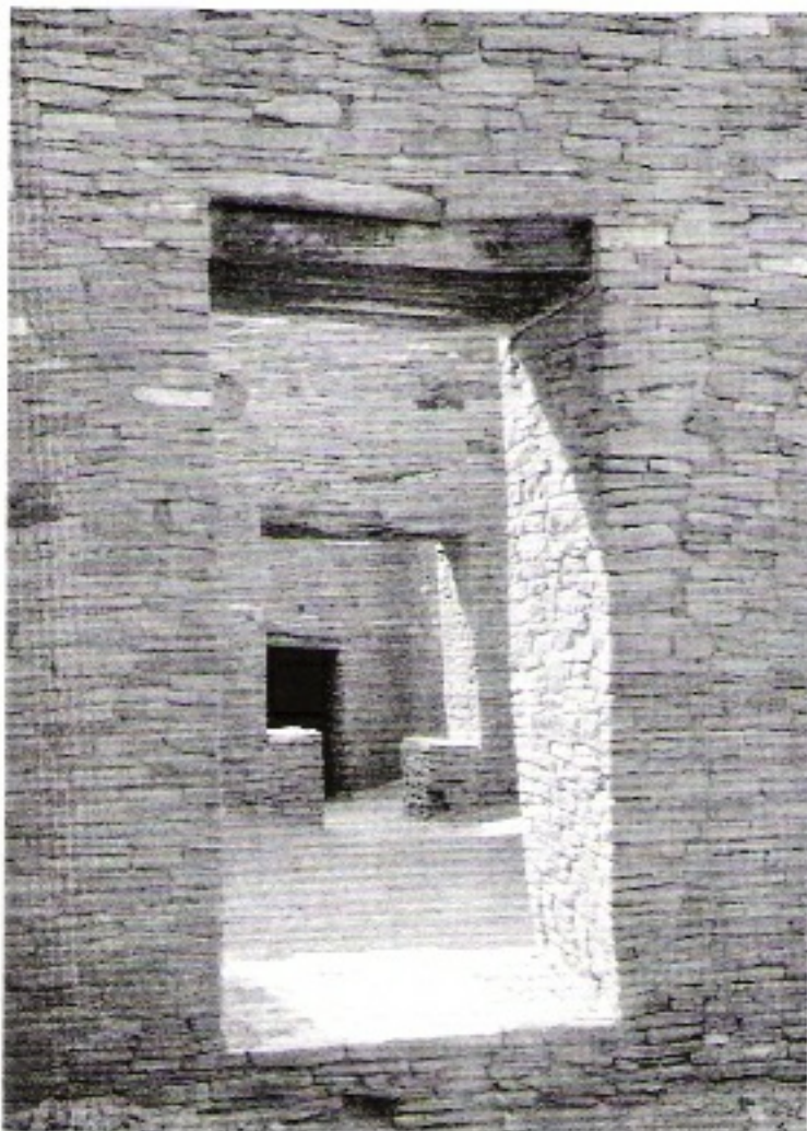
Foto 11. Um portal anasazi, ilustrando a técnica de construção com pedras de encaixe a seco (i.e., não cimentado), com lajes revestindo um interior de entulho.
